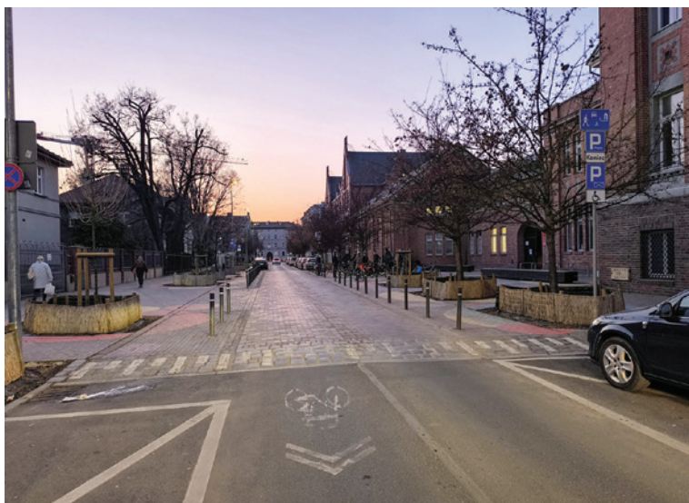
Szkolna ulica w Poznaniu, gdzie wprowadzone zostały strefa zamieszkania, wyniesienie jezdni wzdłuż szkoły oraz inna struktura nawierzchni. Na tak urządzonej jezdni kierowca czuje się gościem.
