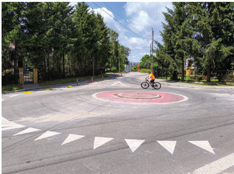
Małe rondo typu pinezka wykonane w miejscu dużej niezagospodarowanej powierzchni skrzyżowania na terenie osiedla domów jednorodzinnych.
