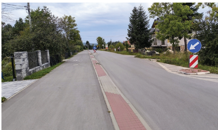
Droga dla pieszych i rowerów wykonana z asfaltu z zachowaniem ciągłości nawierzchni oraz poziomemu niwelety na zjazdach. Dodatkowo na jezdni wykonane zostały szykany a także progi zwalniające. Taki zestaw rozwiązań umożliwia bezpieczne poruszanie się dzieci pieszo i rowerem poza jezdnią a także ogranicza ryzyka związane z przekraczaniem prędkości na jezdni i wypadnięciem pojazdów na drogę dla pieszych i rowerów.
