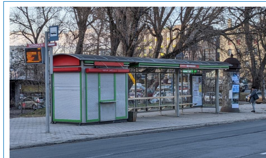
Rys. 6.4 Infrastruktura przystanku autobusowego poza centrum Lublina
