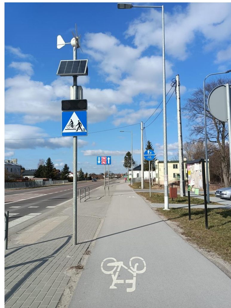
Rys. 6.21 Ciąg pieszo-rowerowy w Jabłonnej Źródło: Materiały własne
